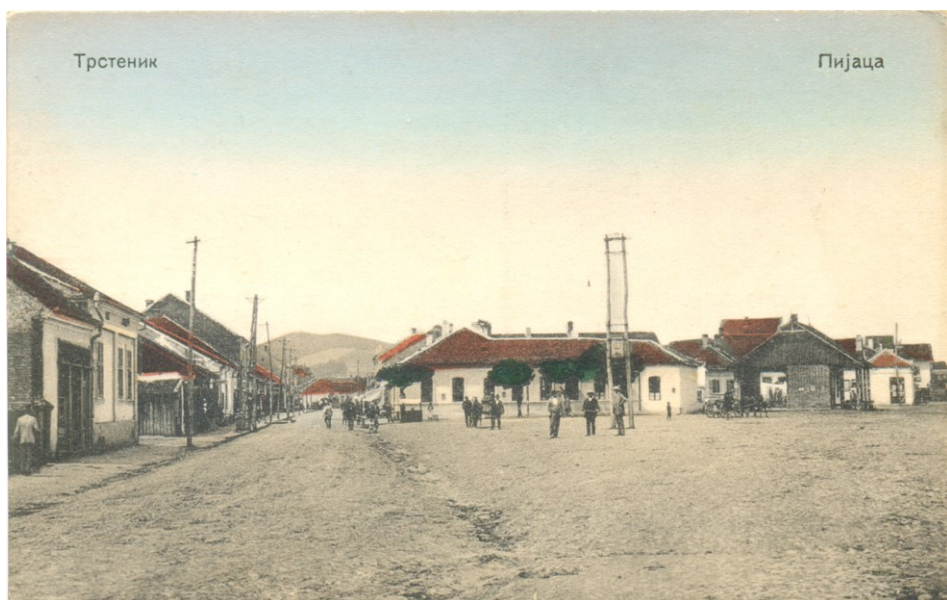
Три Васе Анђелковића са електричним сијубом за развод мреже и трансформатором око 1922. године
